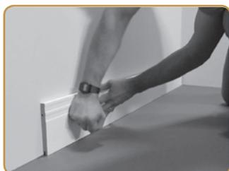
1. **LIMPAR A SUPERFÍCIE:** Recomenda-se limpar bem a superfície a ser aplicada a cola, deixando-a livre de poeira, graxa e umidade. Em paredes pintadas ou com tintas em más condições, recomenda-se lixar previamente antes da aplicação da cola.
