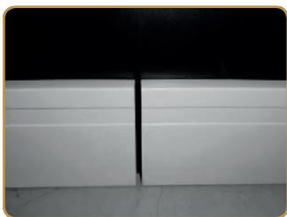
1. Quando for instalar a moldura poliestireno em uma parede ampla, você poderá unir várias barras. Para isso, corte as extremidades das barras em meia esquadria (ângulo de 45°).
