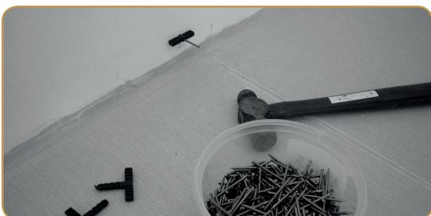
1. **GABARITO:** Faça um gabarito cortando um pedaço de 5cm da moldura a ser fixada. Dentro da canaleta, que está na parte de trás, faça um furo transpassando de lado a lado. Coloque o gabarito perfurado onde será fixada a moldura, marque com um lápis onde será feito o furo. A broca para o furo deverá ser exatamente de 6mm.
