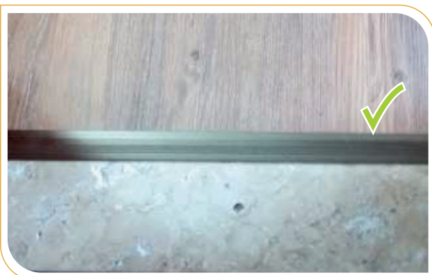
Faixa de arremate com perfil em alumínio
