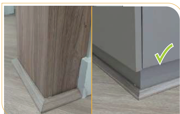
Cordão de acabamento nos pilares e móveis planejados
